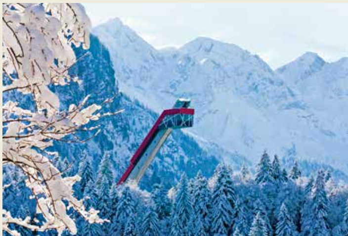
Der „schiefe Turm von Oberstdorf“ ist weithin sichtbar. Foto: Tourismus Oberstdorf / Stefan Betz
